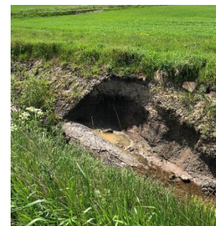
Foto 8 och 9: Ras och erosionsproblem i dikeskant/kanal
