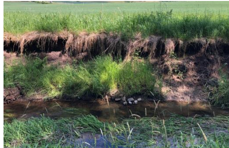
Foto 8 och 9: Ras och erosionsproblem i dikeskant/kanal
